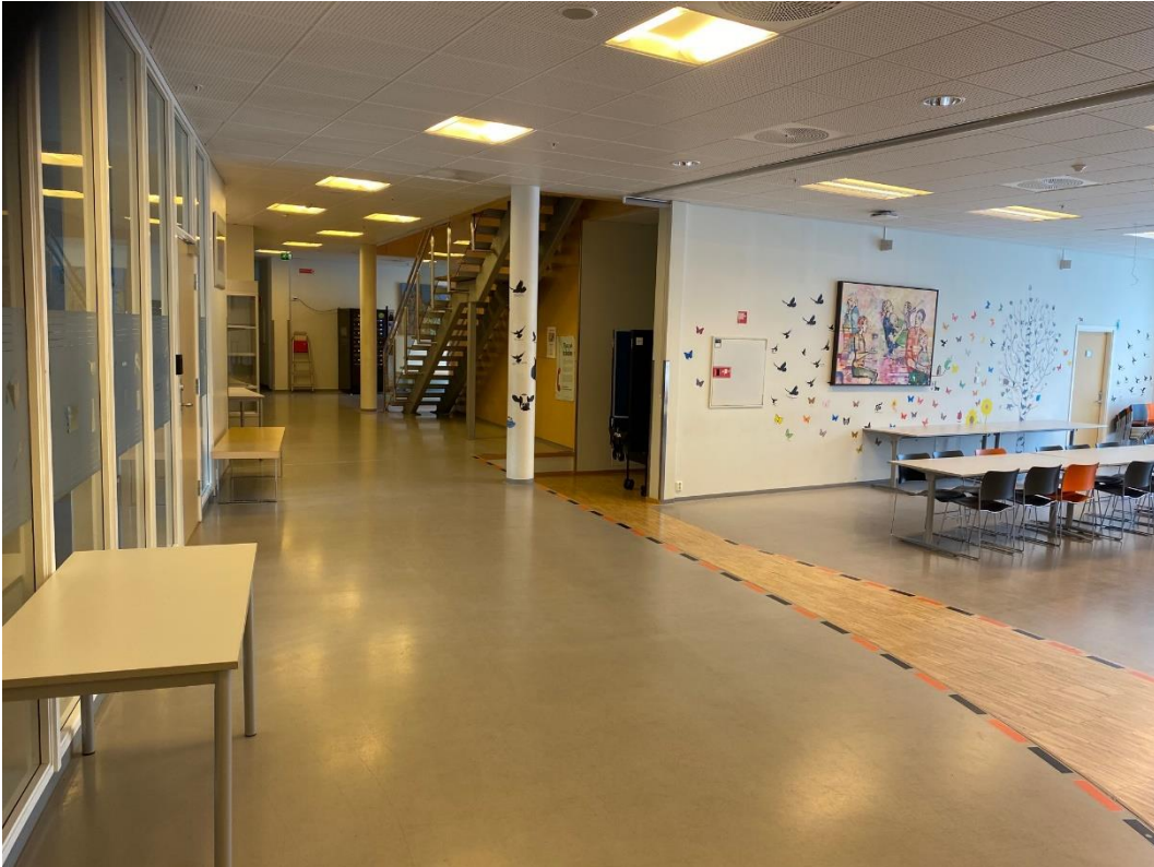
Sidefløy/gjennomgang 2, tak og ventilasjonsanlegg.
