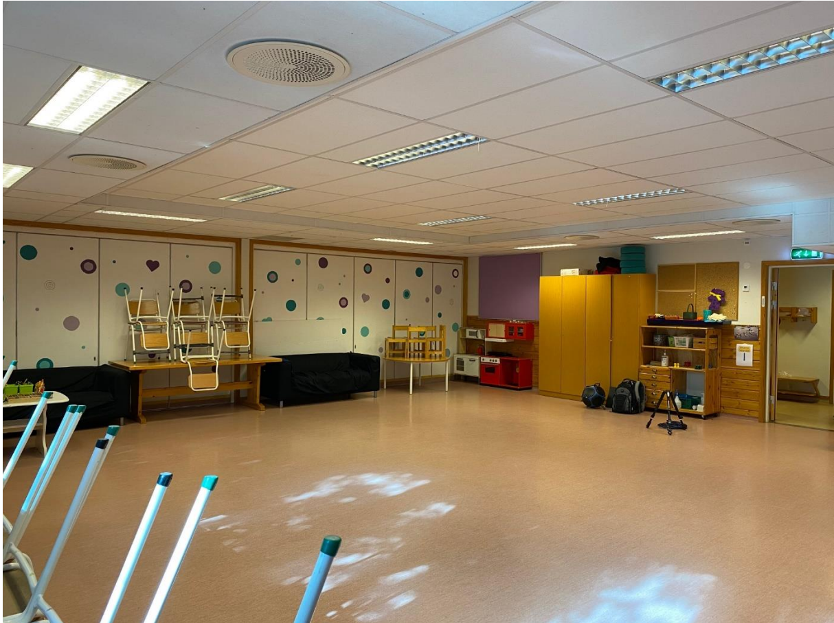
Foldevegg, hjørne, diverse skap. Takplater og ventilasjonsanlegg i tak.
