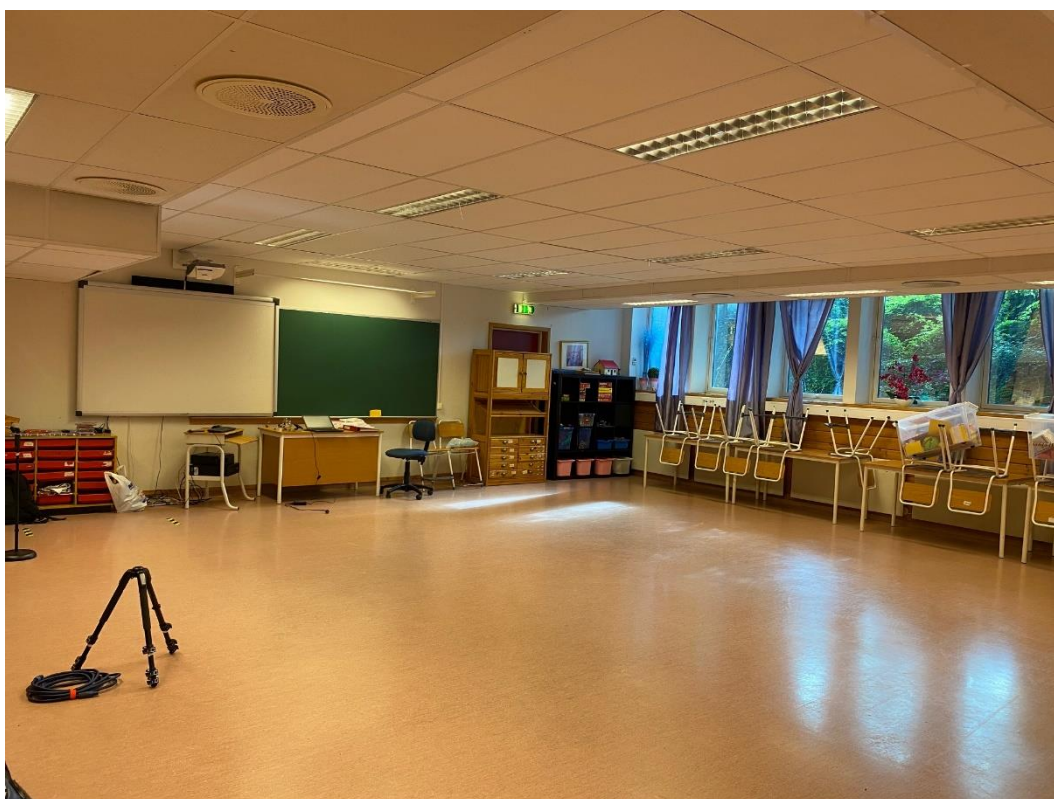
Hjørne. Vindusvegg med brystpanel, Plater i tak. Merk boks til venstre i taket.
