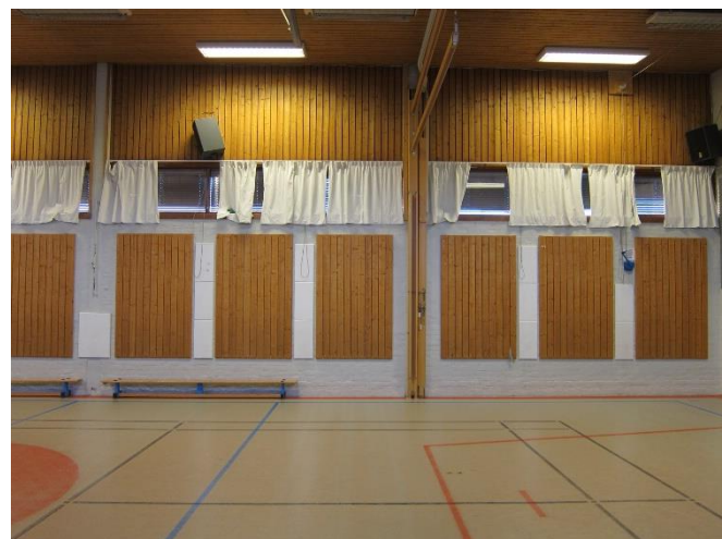
Resten av langveggen med hvite plater
