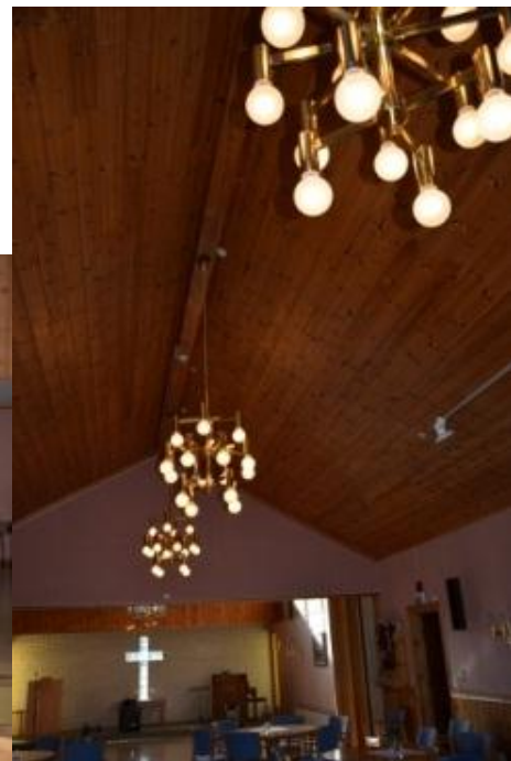
Taket i siterommet
