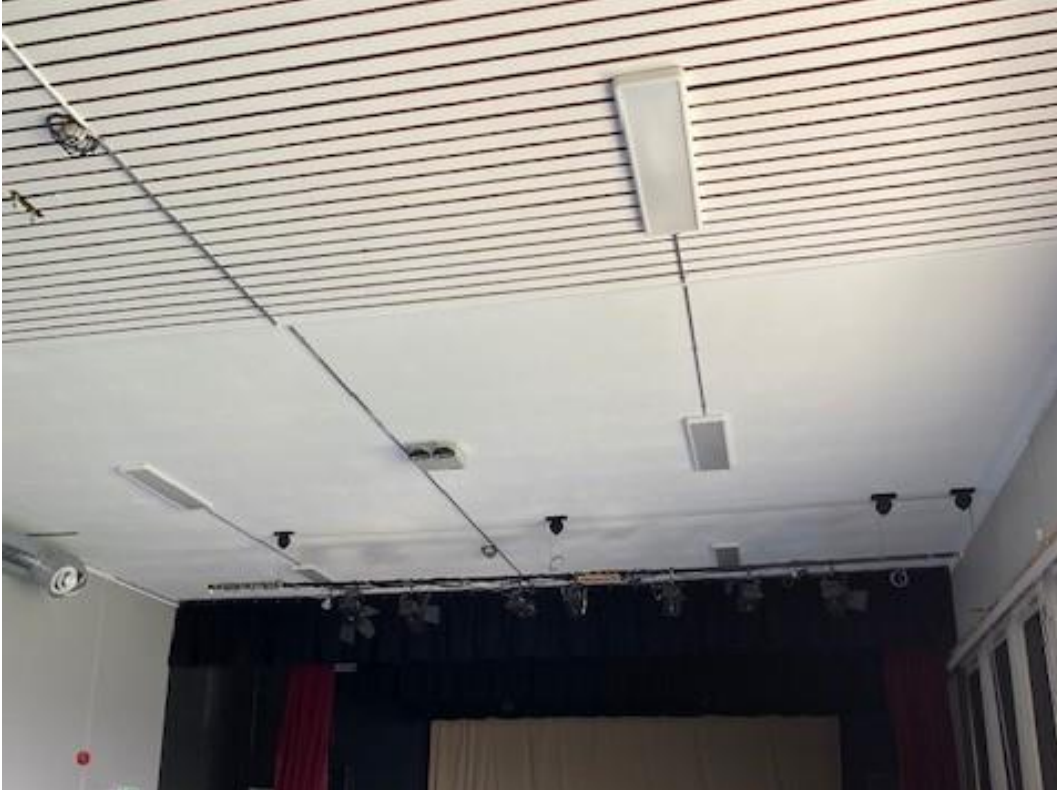
Del av spaltepanel i tak er fjernet etter fagakustikers anbefaling.
