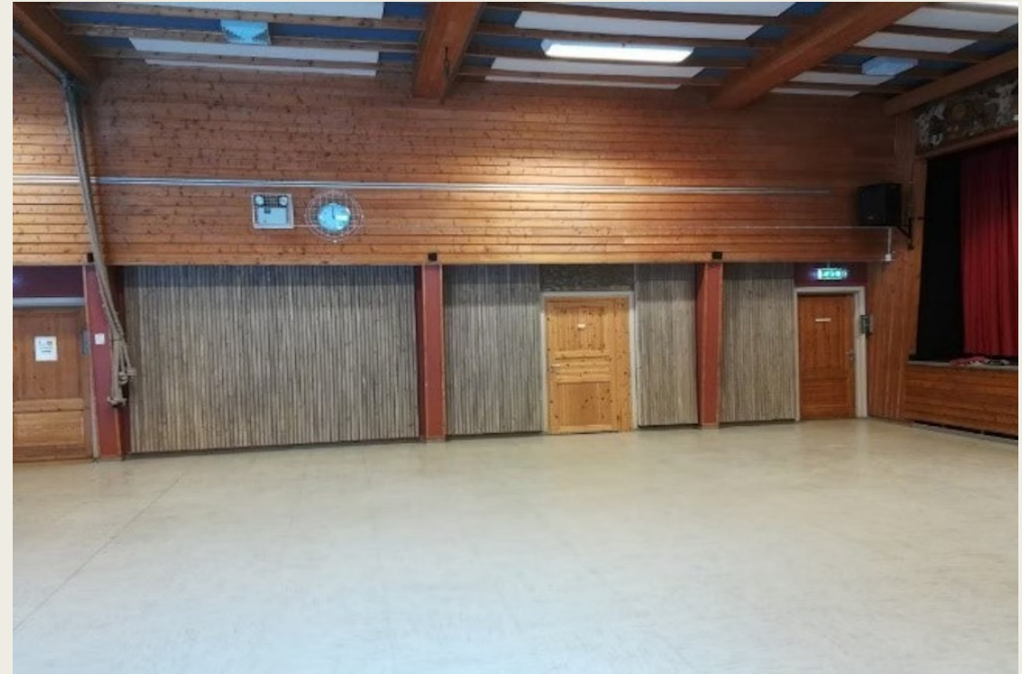
Spilepaneler og takabsorbenter
