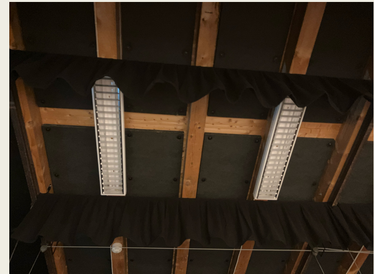
Dempende bakteppe og dempende plater/skjørt i taket. Foto: Rune Borgan Isaksen
