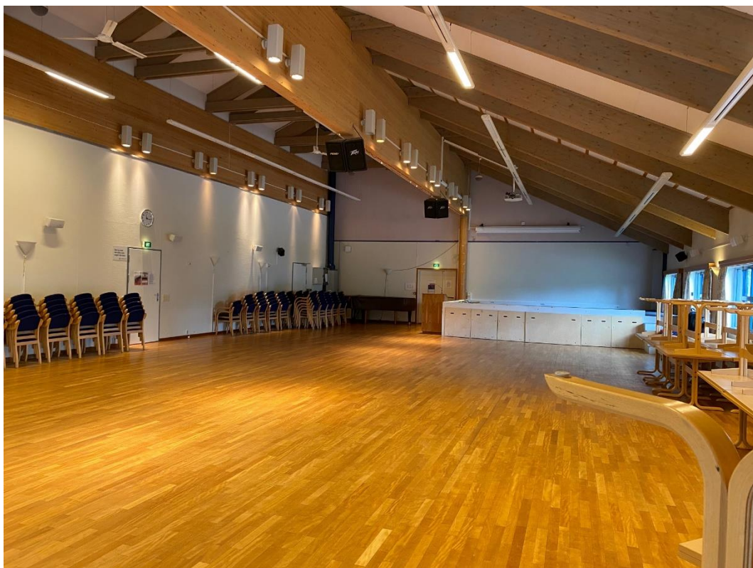
Samfunnssal sett fra inngangsparti venstre. Merk skråtak. Det er montert også absorberer i deler av tak over scene.
